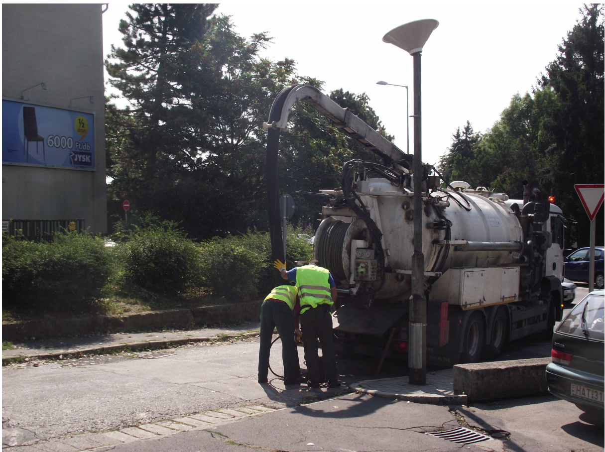
4. kép csapadékvíznyelő tisztítás kombinált csatornamosó célgéppel
