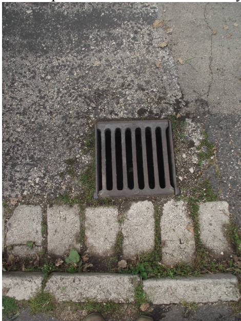
2. kép a bejelentésben szereplő kézi erővel kitisztított csapadékvíznyelő
